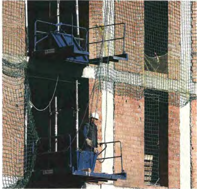
⇒ Un trabajador protegido con casco y guantes, en una obra de Barcelona.
