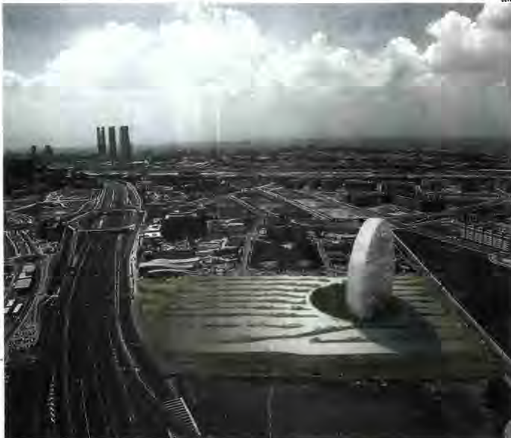
La nueva sede del BBVA, en Madrid, aspira a contar con el certificado LEED de sostenibilidad
