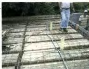
La casa, en su fase de construcción.
