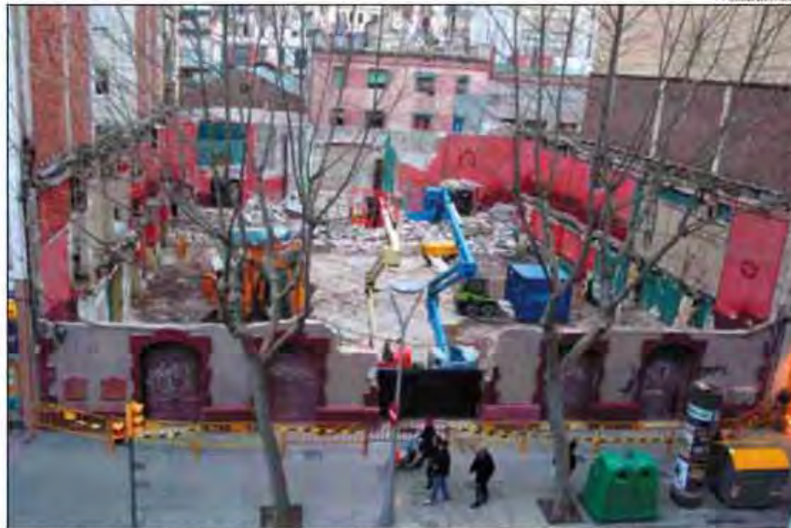
► El solar de la sala Cibeles, con lo que queda de la fachada en primer término, ayer.
