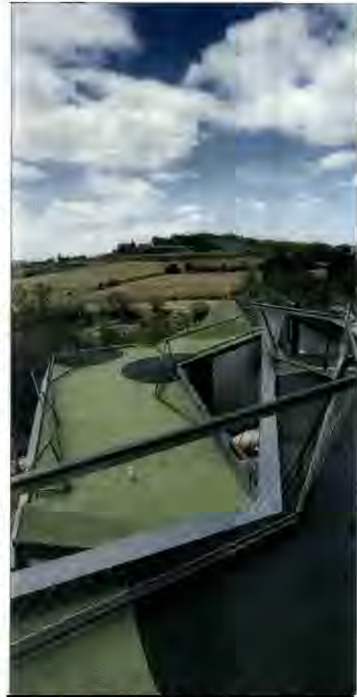
Cubierta de casa Godó de Manel Bailo y Rosa Rull en Igualada (Barcelona).
