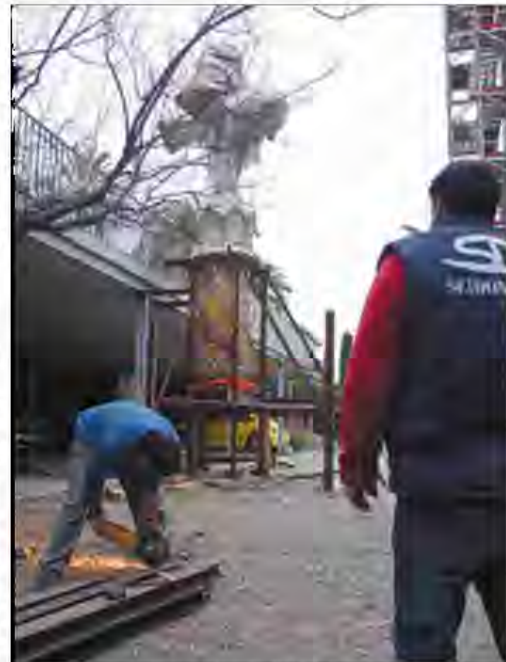
Los obreros preparan la reparación de la cruz, el viernes pasado.
