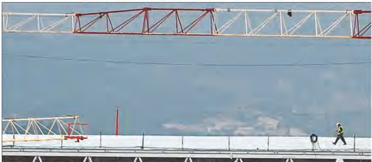
Obras de construcción del nuevo estadio del RCD Espanyol en unos terrenos situados en los municipios de Cornellà y El Prat.
