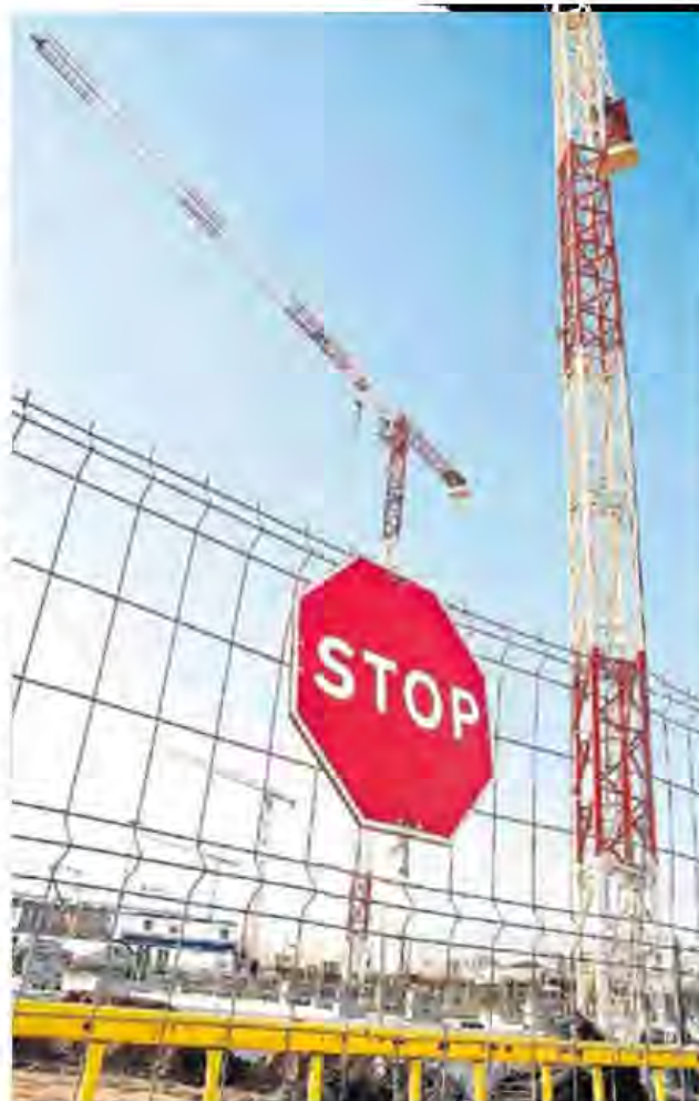
Edificio a medio construir paralizado en el municipio de Cornellà. EDU BAYER
