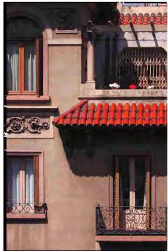
Contraste entre un edificio rehabilitado y otro en rehabilitar en la calle de Balma de Barce
